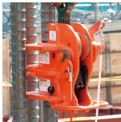
鉄筋吊りクランプ (P.126)
