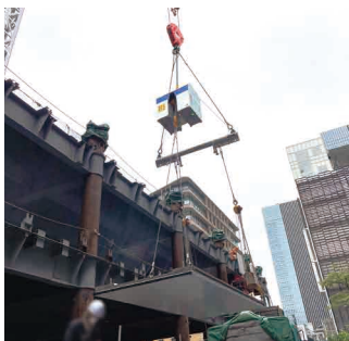
最大吊り荷質量7ton 吊り上げ時 (水平状態)
