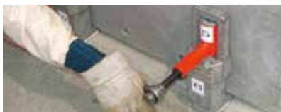
□PC柱高さ調整時
